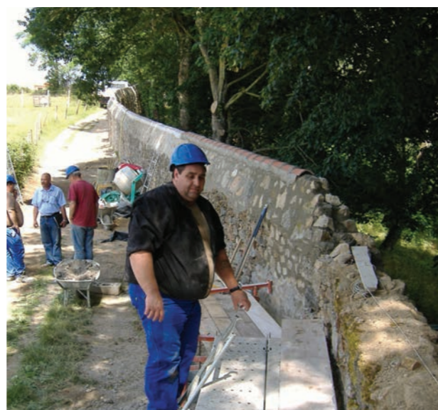
Maçonnerie « pointue » sur mur classé.
